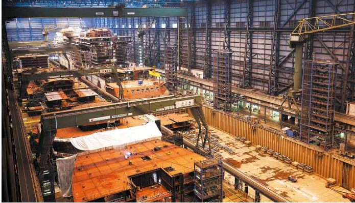
In den Hallen der Meyer Werft Papenburg werden die Teile der gigantischen Schiffe zusammengebaut.
